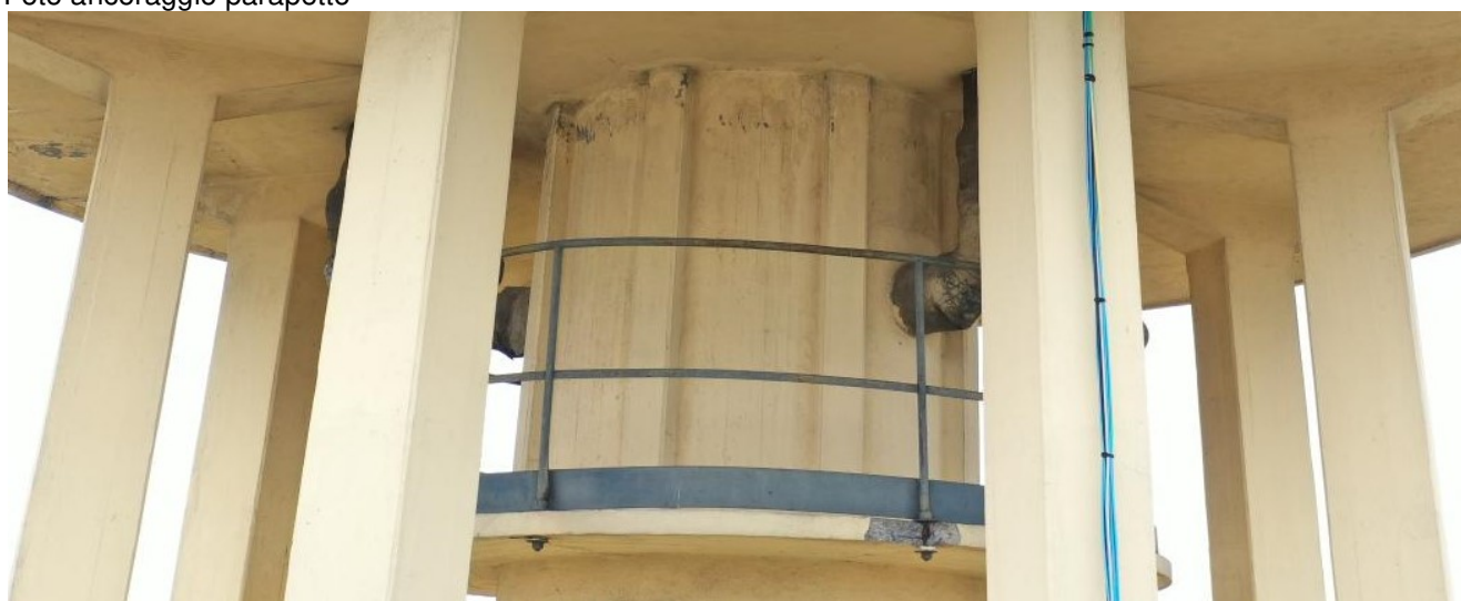
Foto ancoraggio parapetto
